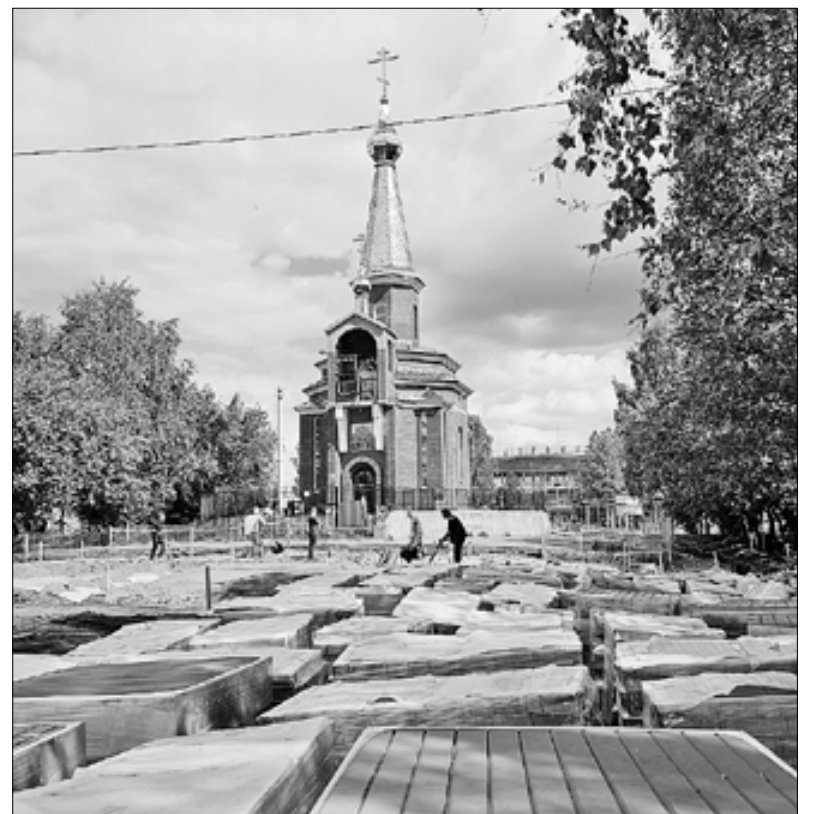
■ Продолжаются работы на привокзальной площади
